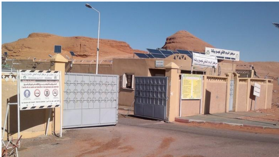
Figure III.1: Vue générale du Centre d'Enfouissement Technique d'Ouargla
