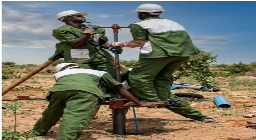
Figure I-9 : Forage à la terre manuel
