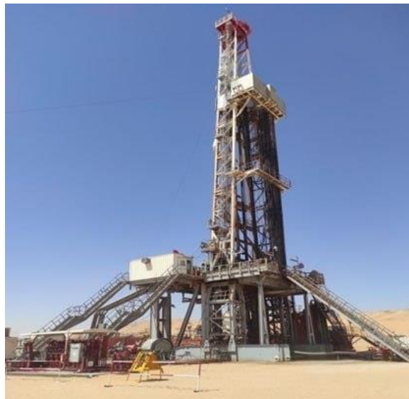
Figure III.2 : Vue générale du site de forage étudié.
