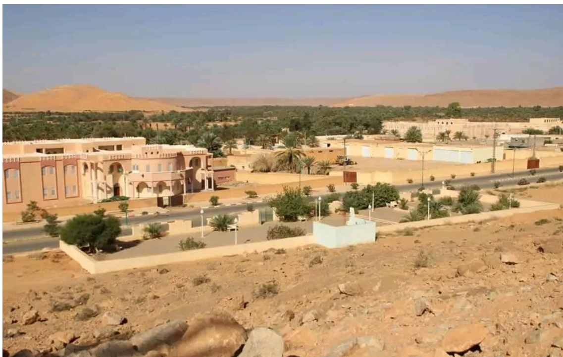
Figure III-4 : Quartier Cité administratif à SEBSEB (vue général)
