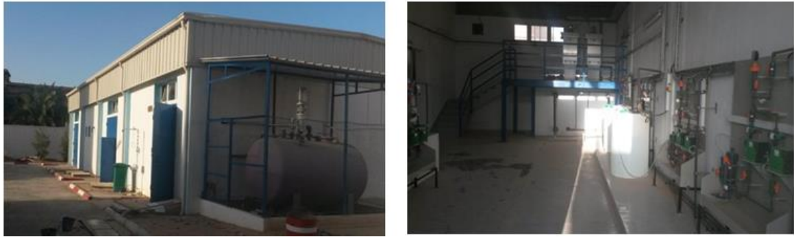
Figure II. 22 : Bâtiment de chloration à la station de GHARBOUZ.
