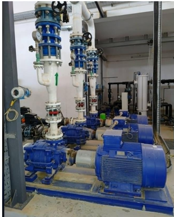
Figure I. 7 : Pompe haute pression
