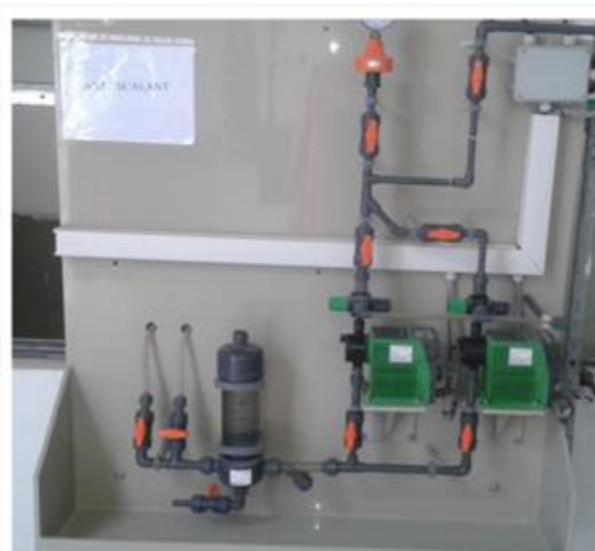
Figure II.18 : Pompe injection d'antitartre (anti scalant).
