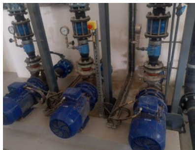
Figure II.14 : La pompe de gavage.
