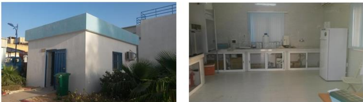
Figure II. 23 : Bâtiment de Laboratoire d'analyse à la station de GHARBOUZ.
