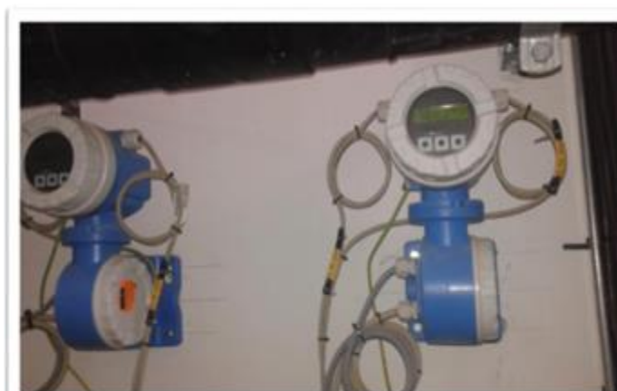
Figure II. 19 : Débitmètre électromagnétique.
