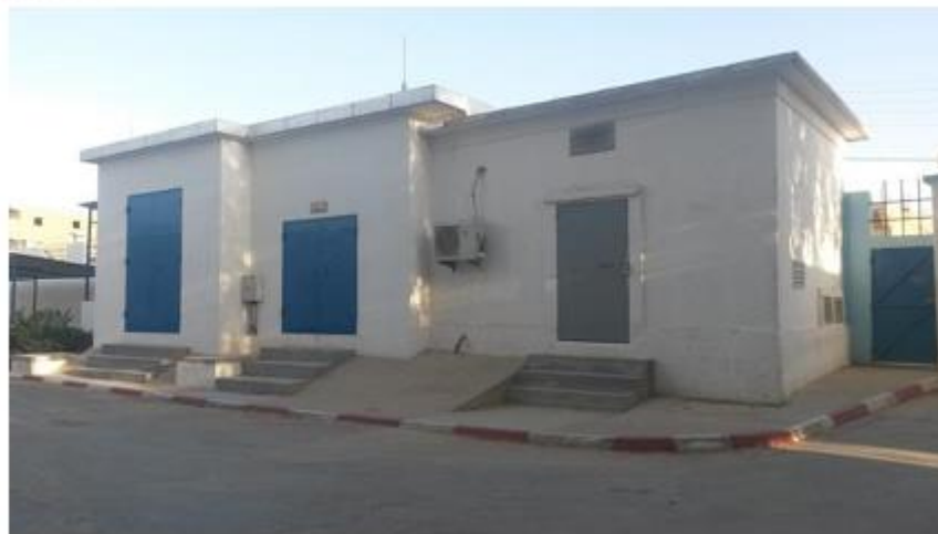
Figure II.25 : Bâtiment Locale d'énergie à la station de GHARBOUZ.
