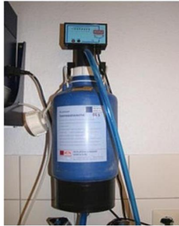
Figure I. 1 : Système d'échangeur d'ions [2].
