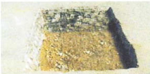
Sondage mettant en évidence les différentes couches de matériaux
