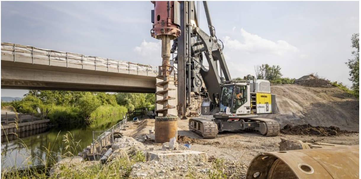
Figure 10 : appareil de forage par battage
