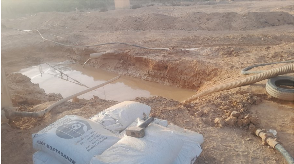
Figure 6 : Bassin de boue
