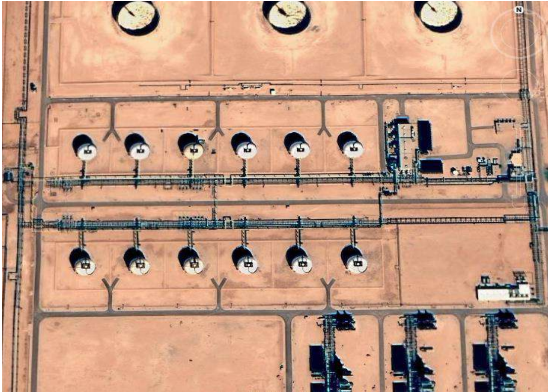
Figure II-5 Centre de Stockage et de Transfert Facilités CSTF
