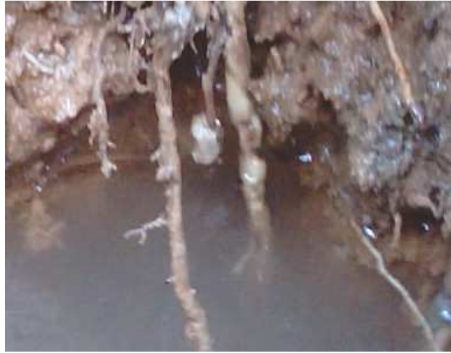
Figure 22. Racines en état d'hydromorphie
