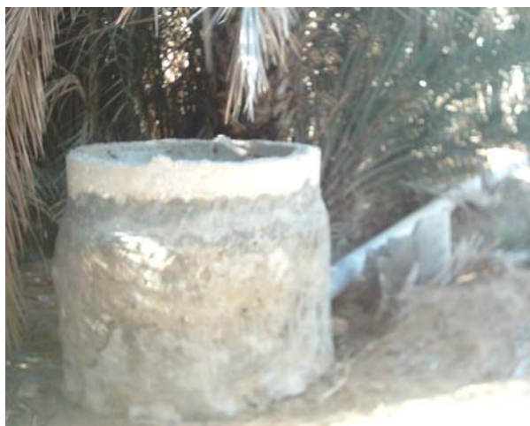
Photo 20. Bassin de distribution d'eau dans la station du Chott.
