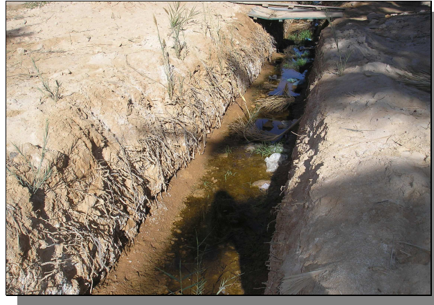
Figure. 17 : L'état du réseau de drainage dans l'exploitation
