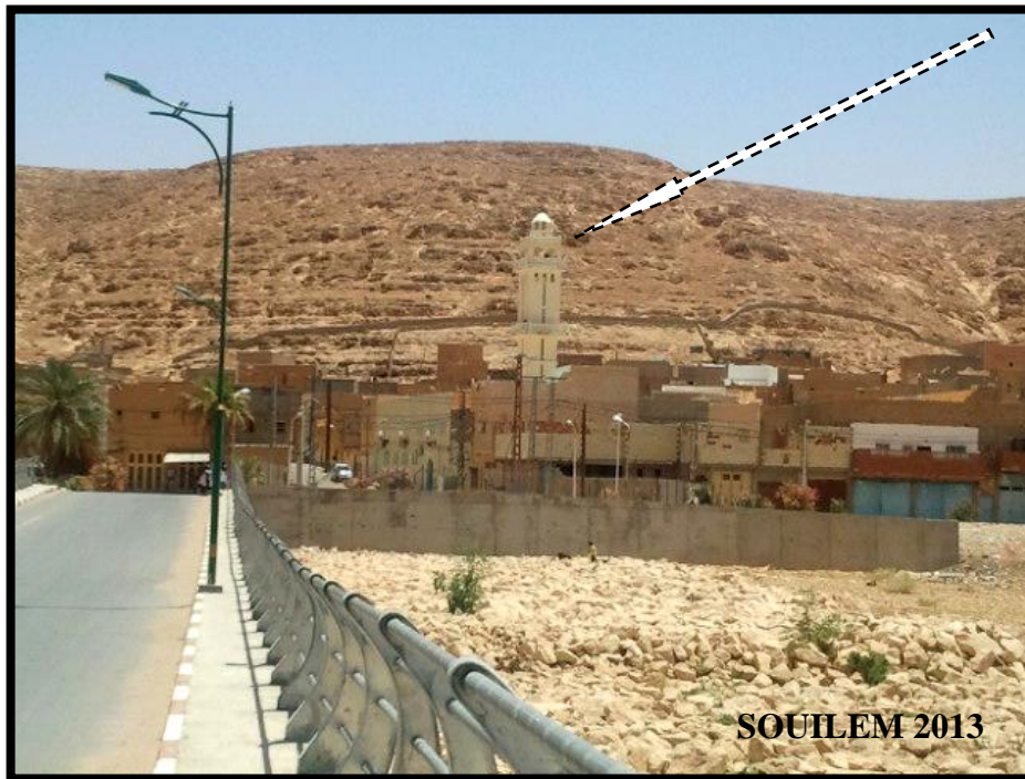
Photo. 2 - Vue général de la station d'El-Atteuf
