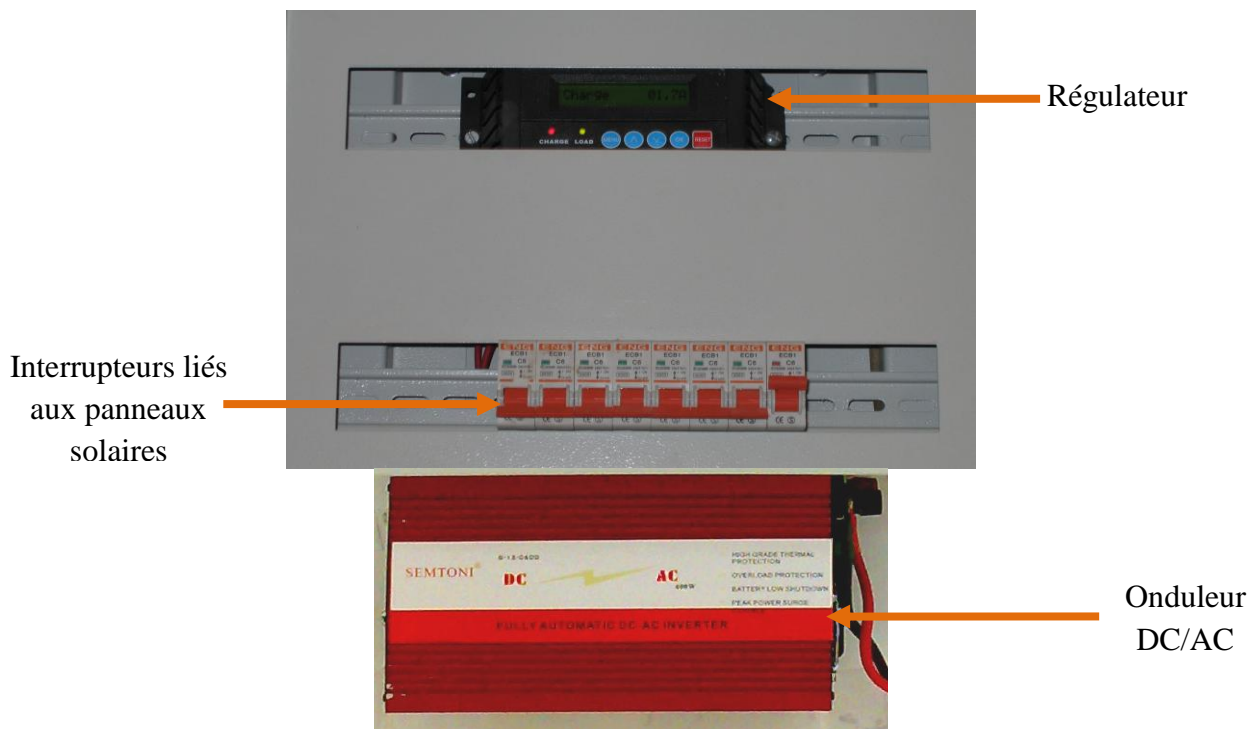
Figure III.5 : Système de conditionnement photovoltaïque
