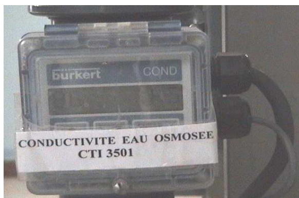
Photo 11 : Conductimètre installé dans le chaîne de traitement.
