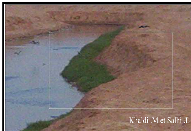
Figure N° (26): état de l'envasement
