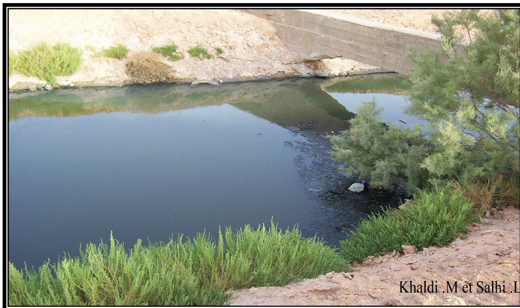
Figure N° (21) : canal de drainage de Bamendil
