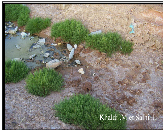
Figure N°(22) : drainage des eaux par les canaux secondaire avec la colmatage et des végétation au bordure du canal.
