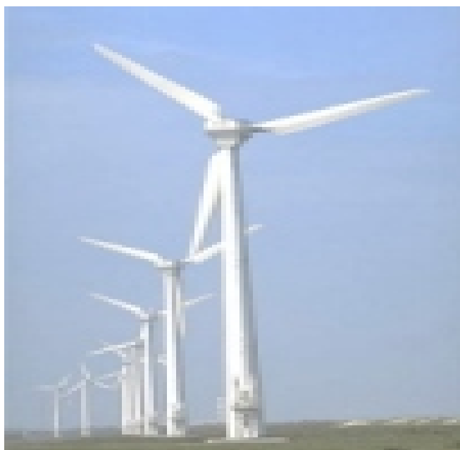
Figure (V-4) : Eolienne
