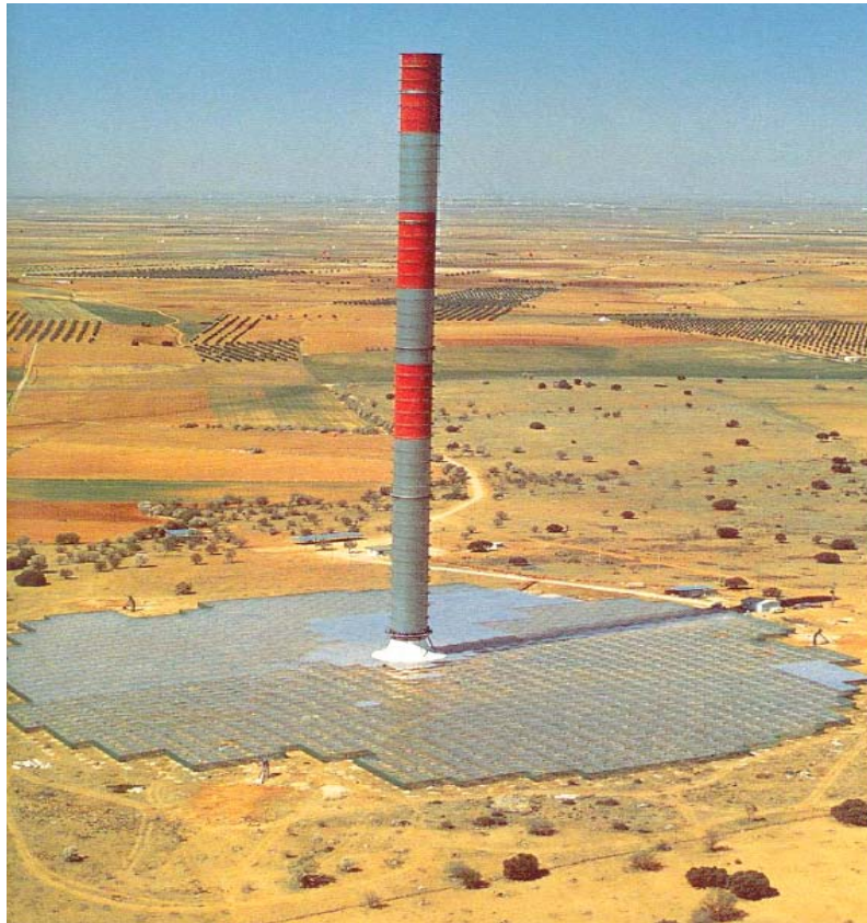
Figure (V-6) : Prototype de la cheminée solaire de Manzanares
