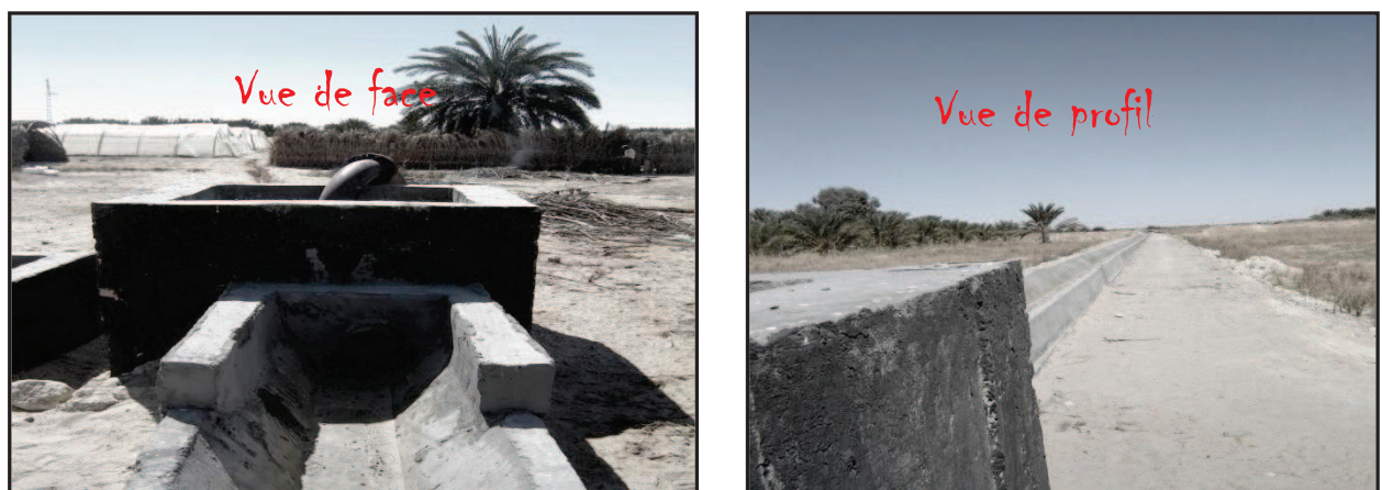
Figure N° 04 : photos d'une Seguia en Béton à Sidi Slimane.
