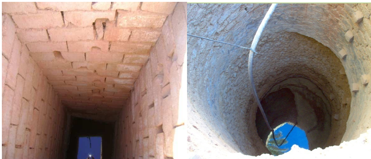
Photo 2- Puits traditionnelles dans la région d'Adrar (Original)
