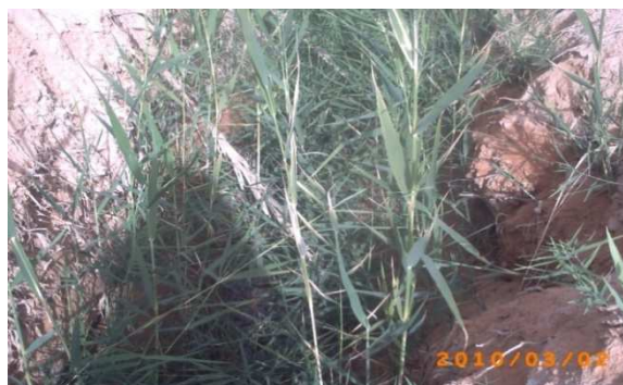
Figure 4: Etat du réseau de drainage.
