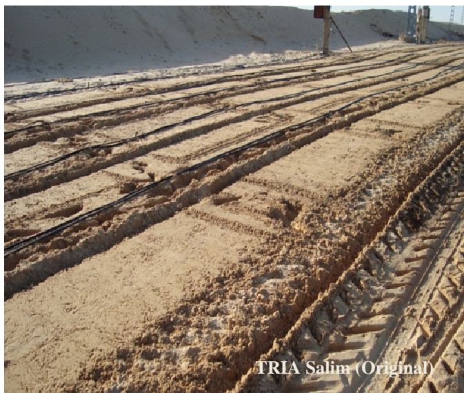
Photo 6. Préparation du sol
