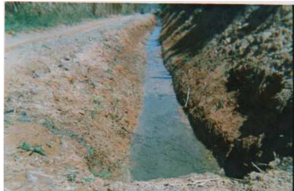
Photo N°14 : Drain après le nettoyage
