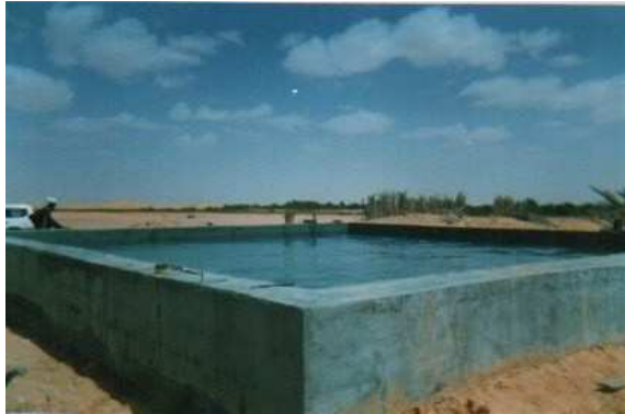
Photo N°9 : Bassin d'accumulation d'eau
