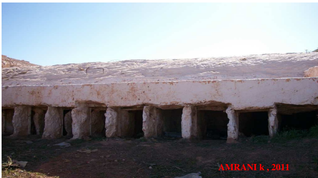
PhotoN°01 : Répartiteur des eaux de crues du M'Zab
