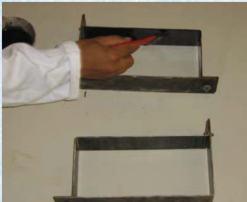
Photo A3 : Graissage des moules crue
