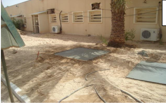
صب الخرسانة للبلاطات الأرضية المستقبلية للنماذج
