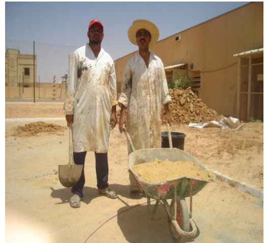
عملية تحضير الملاط الإسمنتي لإنجاز الجدران ( آجر + ميلاط إسمنتي ) .
