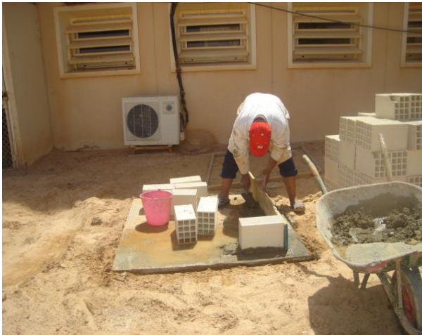
عملية تحضير الملاط الإسمنتي لإنجاز الجدران ( آجر + ميلاط إسمنتي ) .
