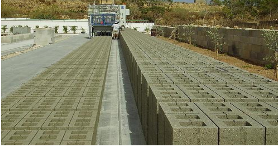
الصورة ( III - 7 ) إنجاز اللبنة الخرسانية
