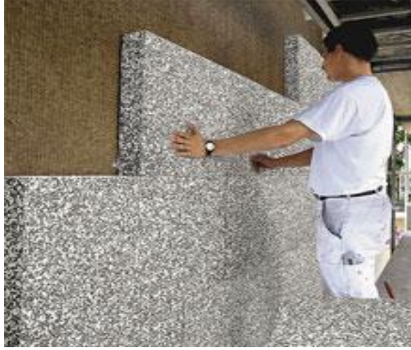
الصورة (12.1): صورة عن تركيب عازل للجدران الخارجية
