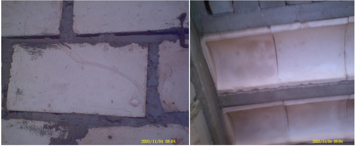
الصورة (III.15): إستعمال لبئات جبسية للسقف والجدران بمدينة سيدي خويلد - ورقلة -
