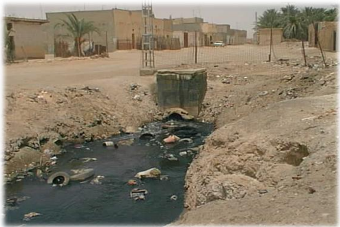
Photo: 1-IV Affaissement de sol au cité de Avenu 17 octobre sur la commune de Touggourt
