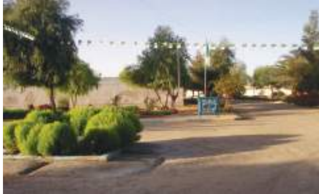
Fig22 : photo de la station d'épuration de Touggourt. [14]
