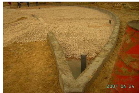
Photo 4 : Remplissage du bassin avec le gravier
