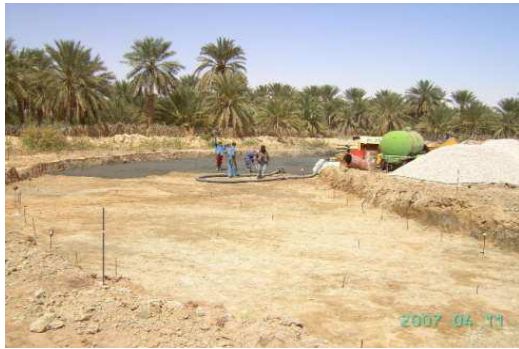
Photo 1 : Excavation du bassin WWG
