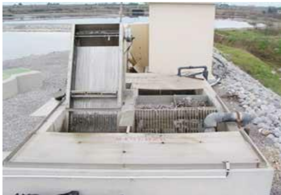
Figure(3) : le prétraitement eaux usées
