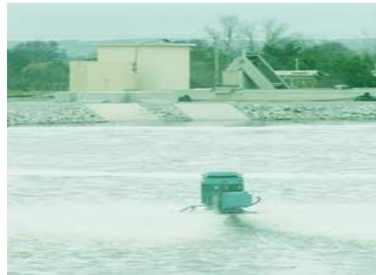
Figure (4) : Lagunage aéré
