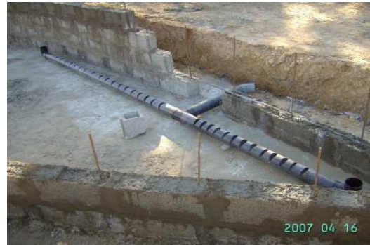
Photo 2 : Placement des tuyaux dans le Son remplissage avec le béton.
