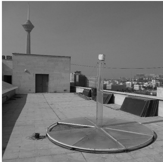
Figure (III-1): Cheminée solaire de Téhéran
