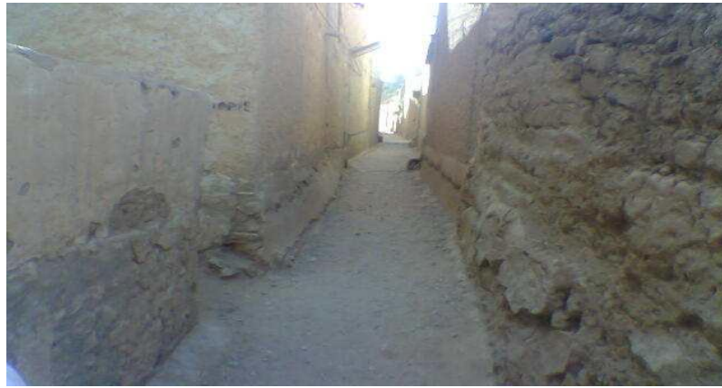
Figure2.2.Les chemins utilisés comme des canaux d'alimentation en eaux.
