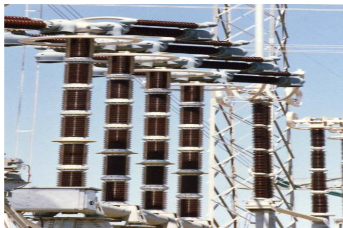
Figure II.5 : Disjoncteur à air comprimé
