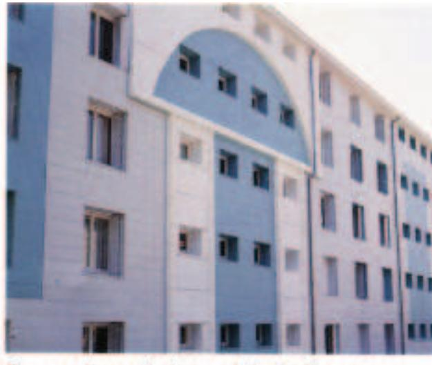
Photo I.3- panneaux légers et colorés en béton de fibres de verre [4]
