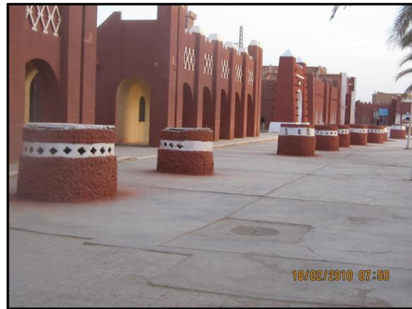
Figure 3. Une série de puits synonyme de l'existence d'une galerie souterraine (Abidi N. et Remini B., 2011)
