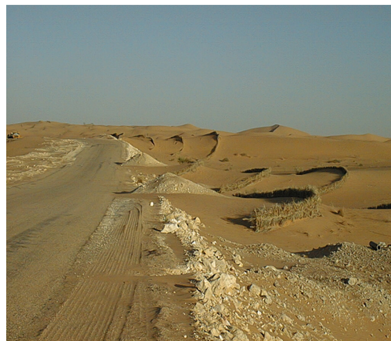
Figure 3 : Photo de palissade d'arrêt (a) et photo de palissade de défilement (b) RN53A
