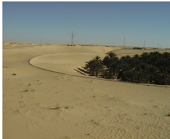
Figure 7 : Clôture de désensablement des jardins
