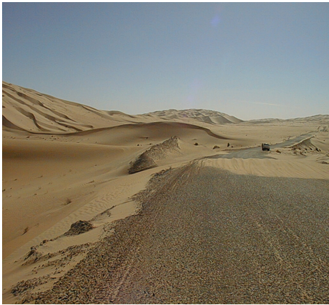
Figure 4 : Photo d'envahissement de la route par du sable, RN53A
