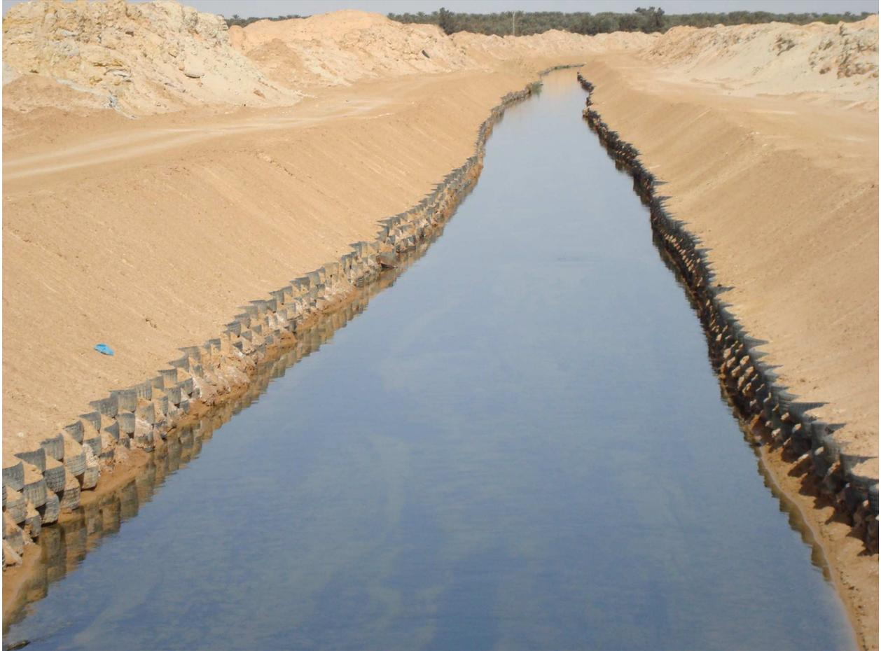
**Photo II.3** Emplacement des pneus à la station de Ranou (Février, 2008)
