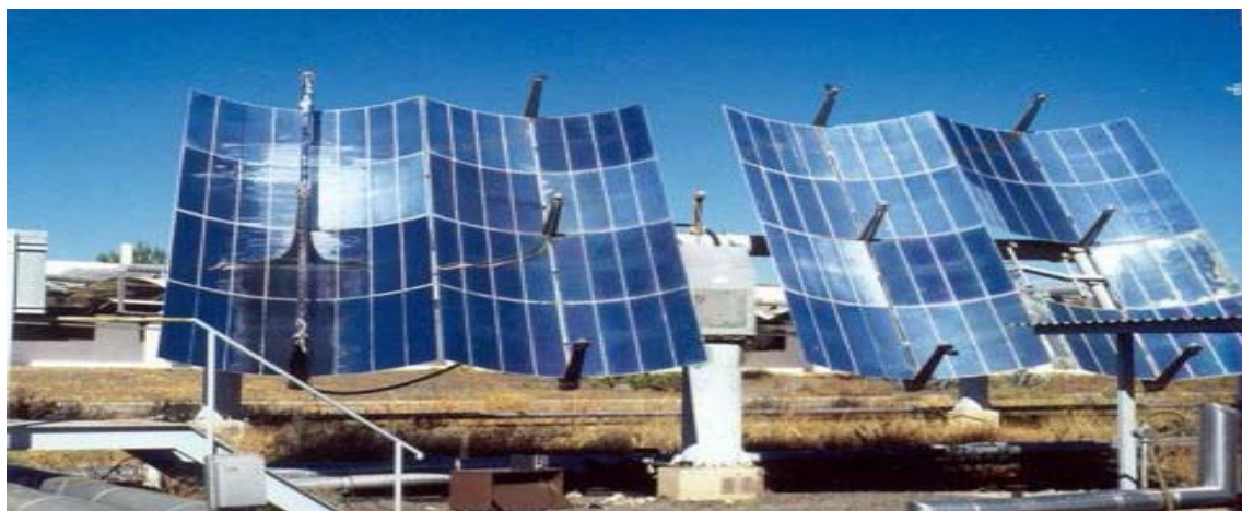
Figure (II-16): Capteur solaire à concentration en auge parabolique doté d'un système de suivi du soleil à deux axes.
