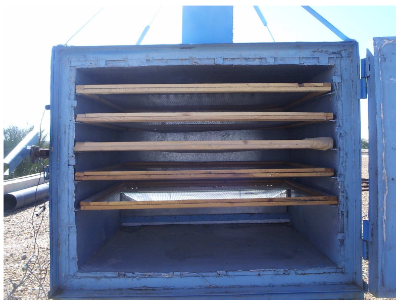
Les clais de la chambre de séchage
