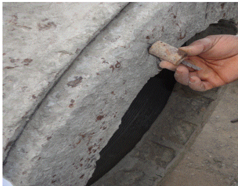
H : Emplacement du mouchons au câbles
