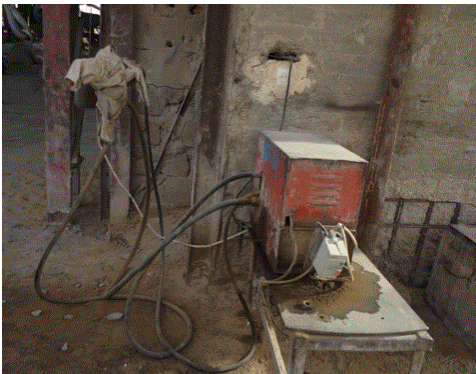
G : Pistolet de vérin pour le tirage des câbles
