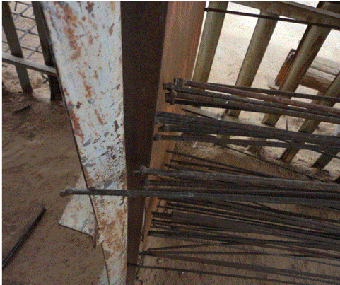
C : Création des soudures aux câbles de précontraintes
