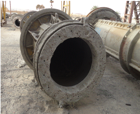
E : Préparation des moules des conduites
