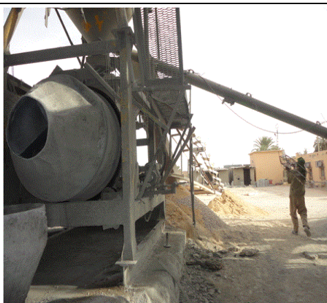
I : Bétonnière de préparation des gâchés du béton
