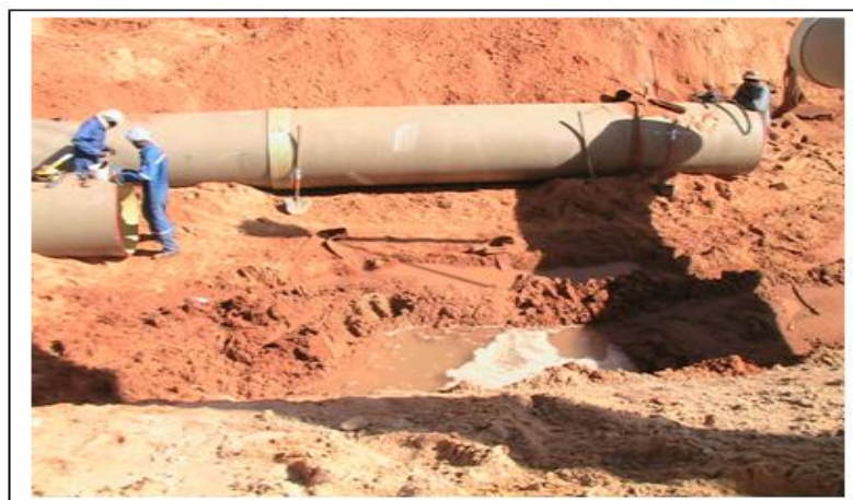
Photo (I, 01): Emplacement des conduites en PRV dans le projet d'assainissement de Ouargla. [14]
