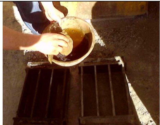
B : Huiler les moules avant le coulage
