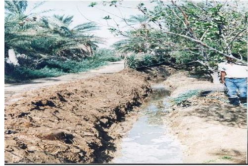
Photo n°16 : Curage de drain
