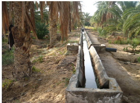
Photo n°17 : Conduite d'amenée d'eau
