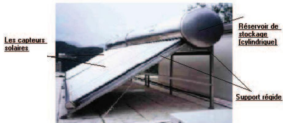
Figure 1.3: Les chauffe-eau solaires monobloc
