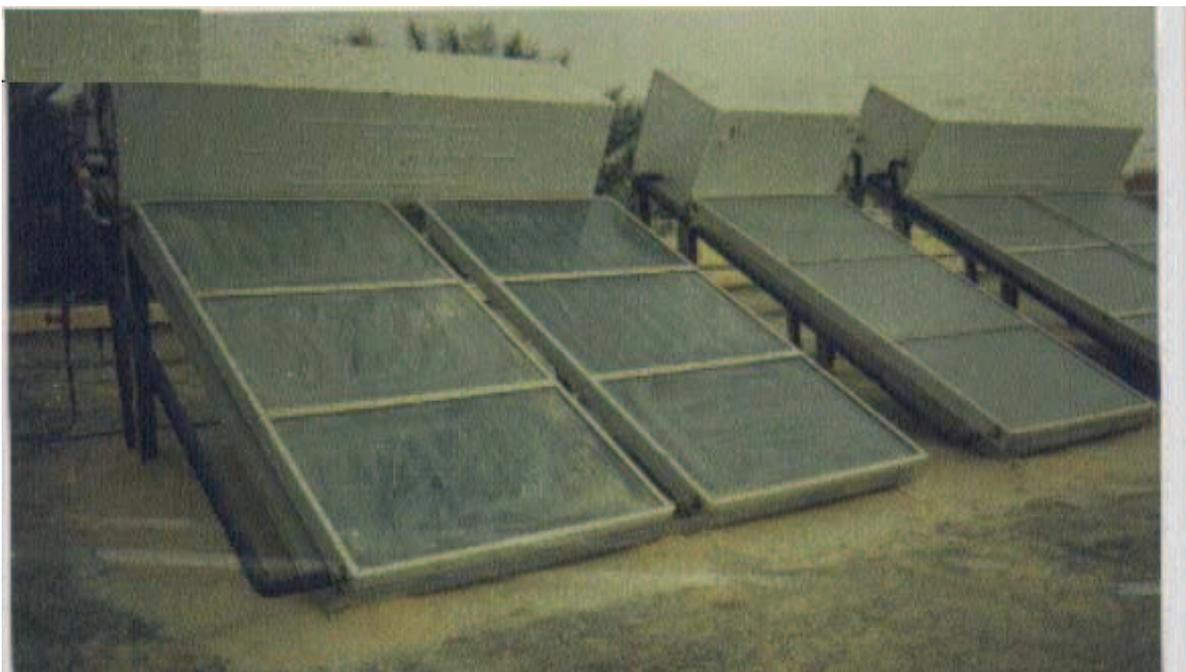
Figure 1.1: Chauffe-eau solaire fonctionnant en thermosiphon
