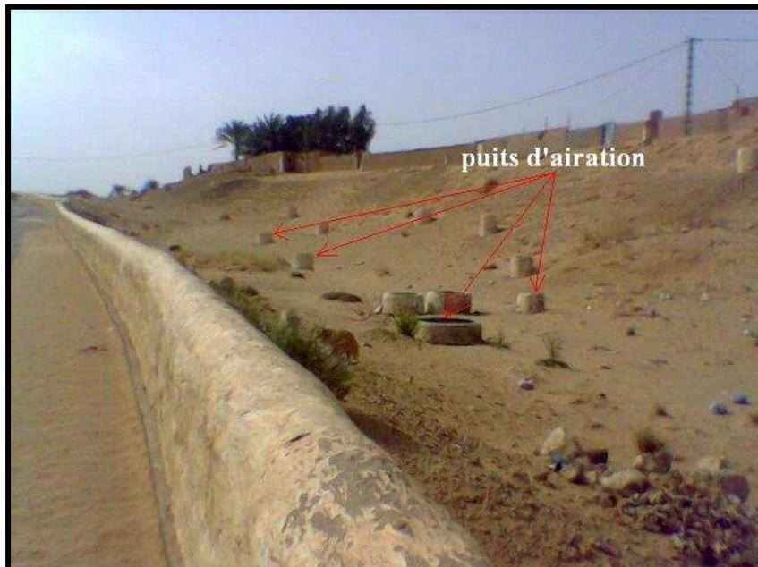
**Photo (10) :** Les puits d'aération.
