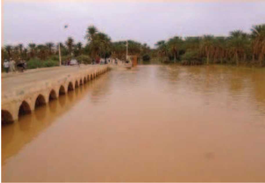
Photo 02 : Digue de dérivation de la crue de Oued Zegrir (HARIZ, 2008).
