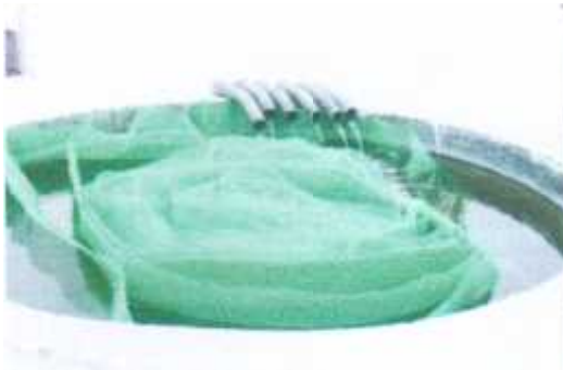
Figure 10 : L'eau évacuée par trop-plein
