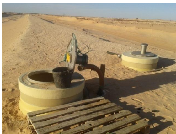
Photo 16. Piquage des EUE au sein du canal pour irrigation
