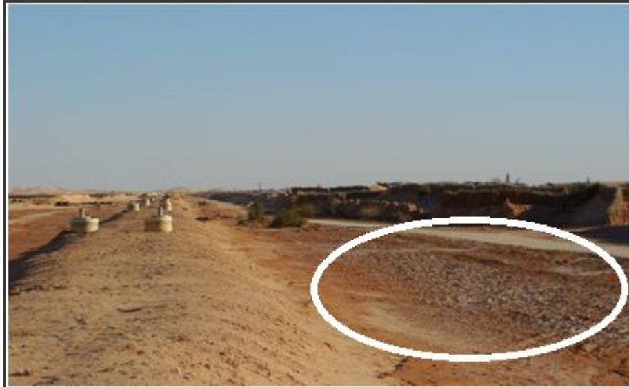
Photo 20 : Remontée de la nappe au voisinage du canal due au manque de drainage.
