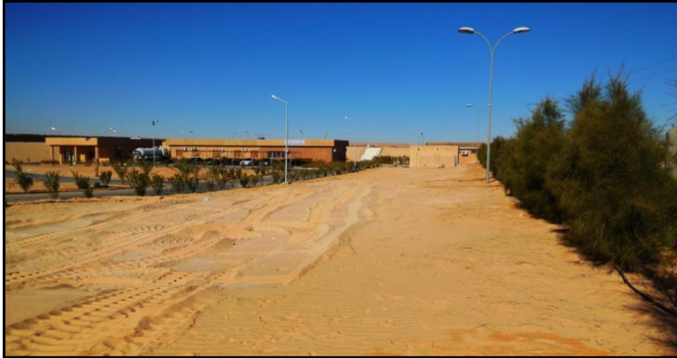
Photo 9 : Nivèlement du terrain.
