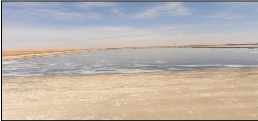
Photo 8 : Bassin de finition.
