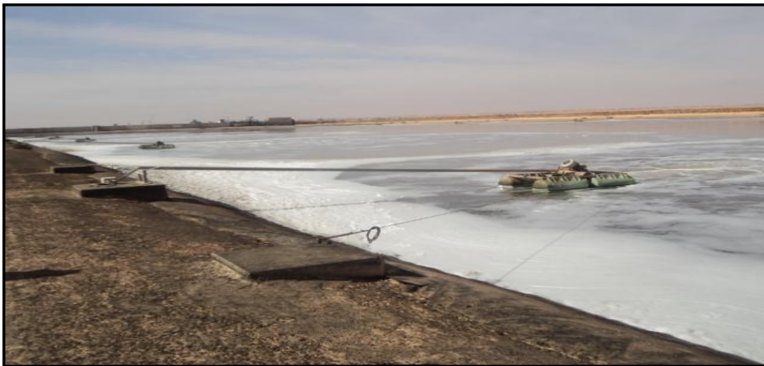
Photo 7 : Aérateur artificiel en fonctionnement.
