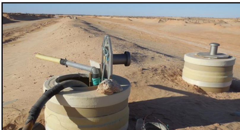
Photo 4 : Regard sur le canal utilisé pour le pompage des eaux usées épurées.
