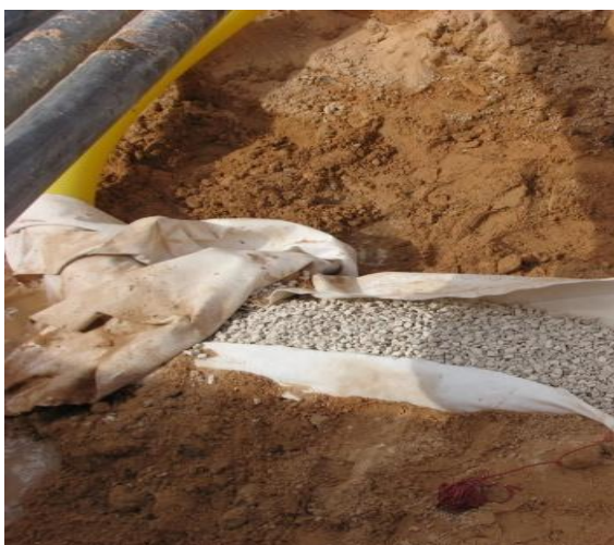
Photo 15: Dispositif de conduite de drainage ( NEGAIS, 2007 ).
