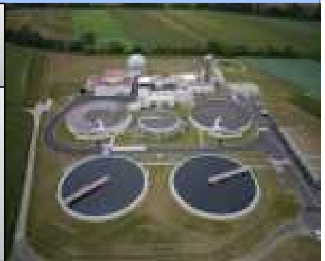
Titre : station d'épuration
