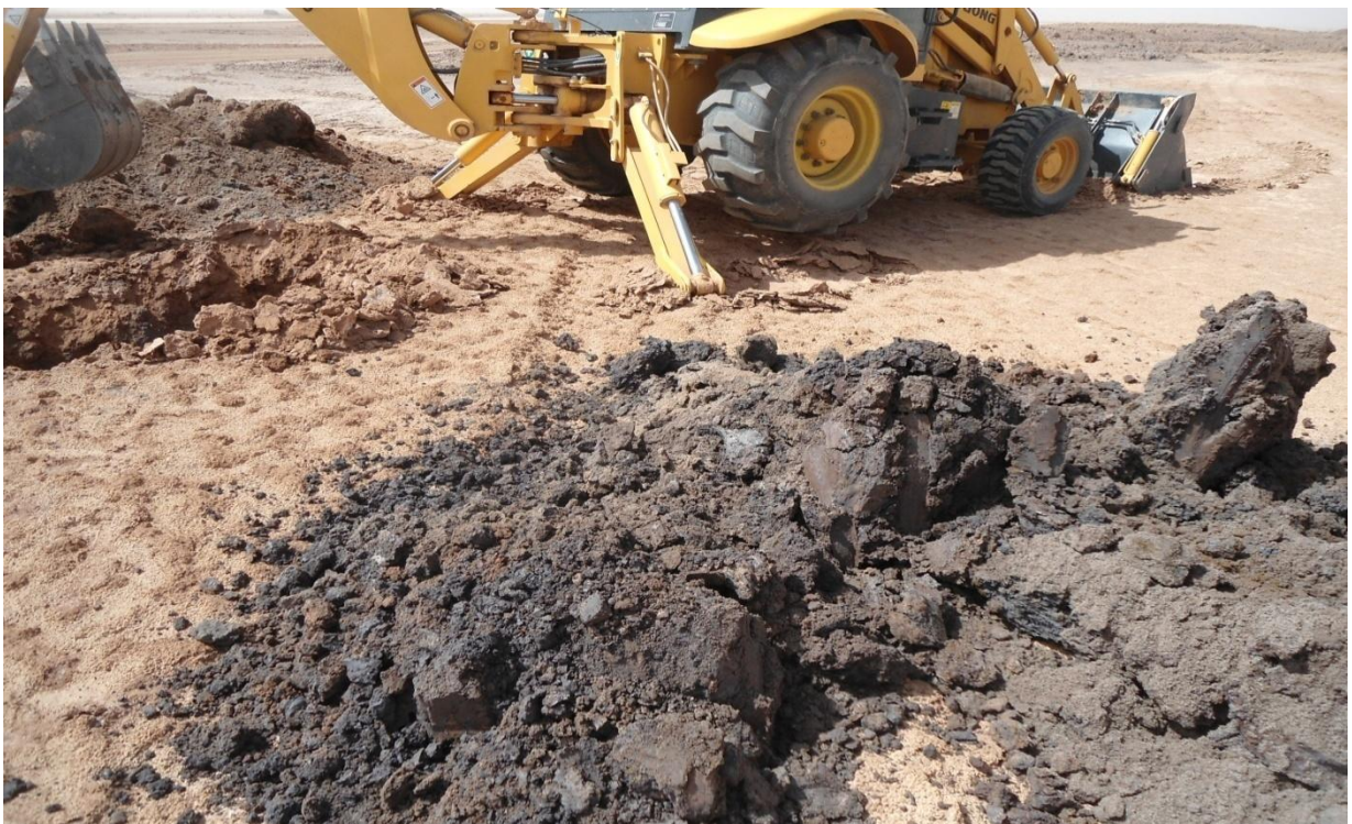
Photos IV-5 : prélèvements d'échantillon d'argile à partir d'un puits creusé à côté de la piste de l'aérodrome d'In Salah
